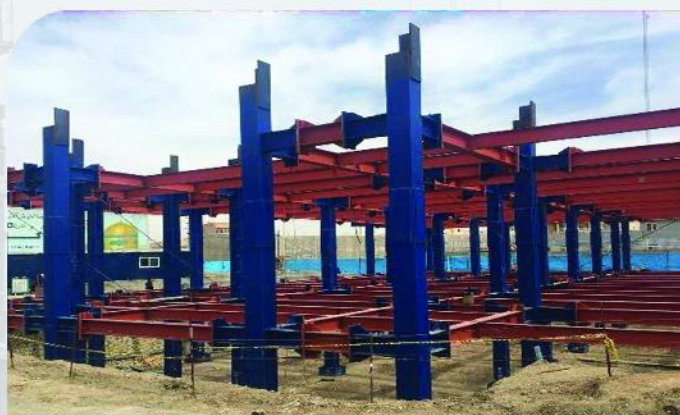
ساختمان درمانگاه تخصصی تامین اجتماعی شعبه فشافویه
